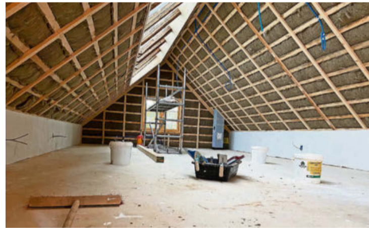
Der Dachstock ist geräumig und dank den neuen Dachfenstern hell. Hier können sich die Mieter frei bewegen, arbeiten oder verweilen.
