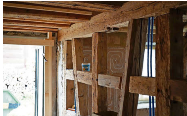
Die 250 Jahre alten Holzbalken wurden freigelegt und wieder sichtbar gemacht. Sie werden so belassen. Fotos: Luca Da Rugna
